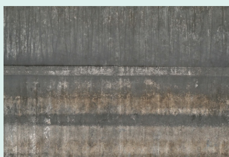
Fig - 3 - Falha no cladding
